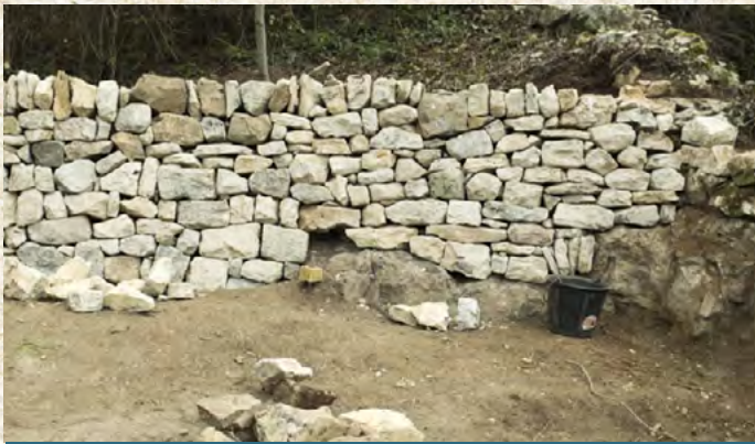
1. Remontage d'un mur en pierre sèche sur le bord de la calade, face au grand lavoir (Cliché Loïc Saint-Jalmes).
