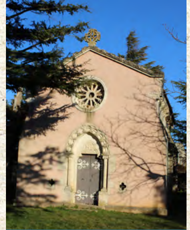
3. La façade et le portail de la chapelle.
