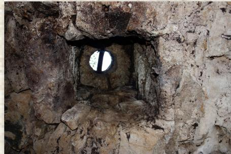
**13** Moulin de Patroux, le passage dans la voûte pour l'axe et l'anille de fer encastree à la face inférieure de la meule tournante.
