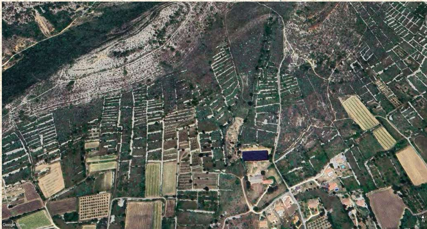
1 Les terrasses des Costes à Saint-Remèze. Image Google Earth.
