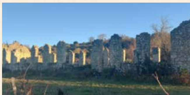
2 Ruines de l'ancienne fabrique, quartier Vitrolle.
