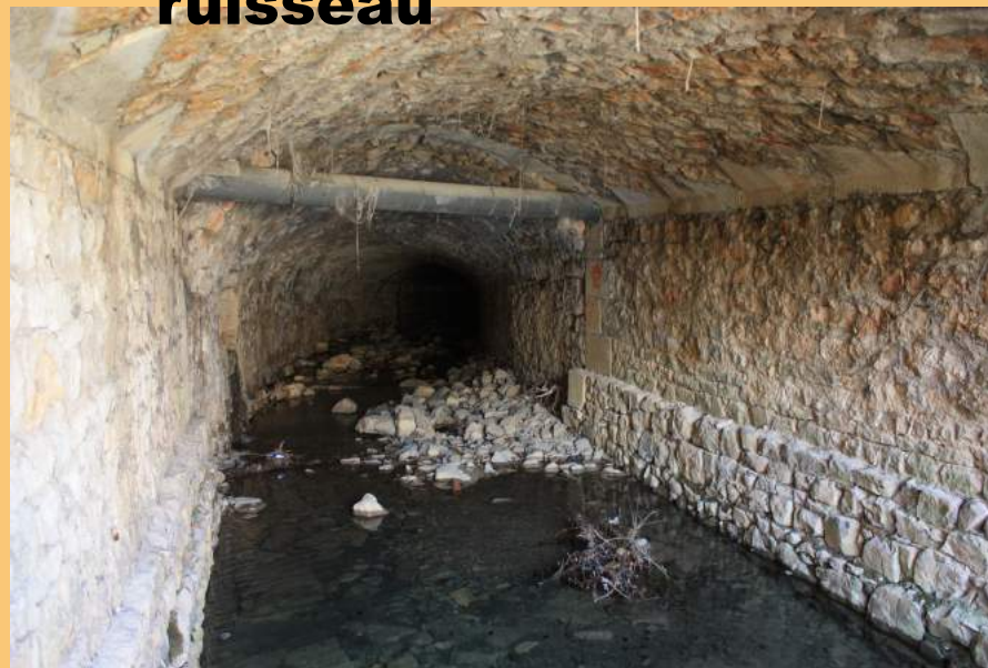
Passage sous la D4 et le long du Barry.
