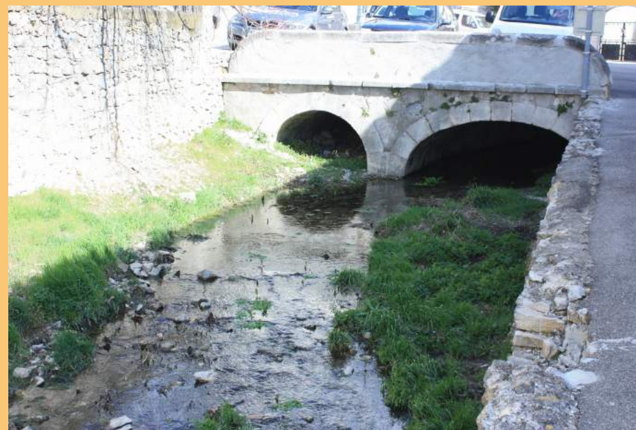
Sortie Place de L'Alambic, avec les deux voûtes : Les Fonts et Berc.
