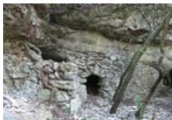
*Grotte-bergerie du Perthus, à la sortie de la combe d'Agrimont, sous un surplomb rocheux. L'espace intérieur ouvre par une porte arquée, construite à claveaux, assez basse. Superficie intérieure : 40 m<sup>2</sup>.*
