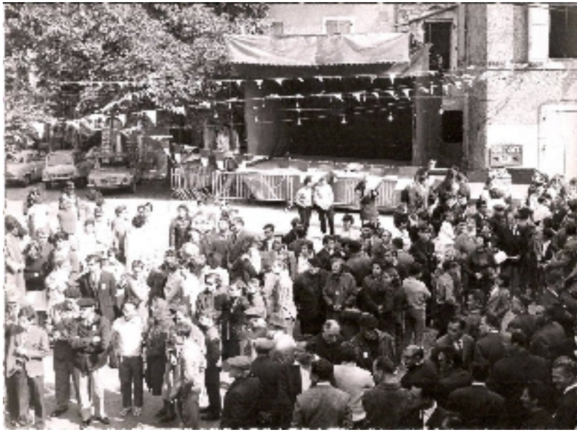
Inauguration de l'Avenue du Maréchal Leclerc, le 10 septembre 1967, Place de l'Esplanade.
